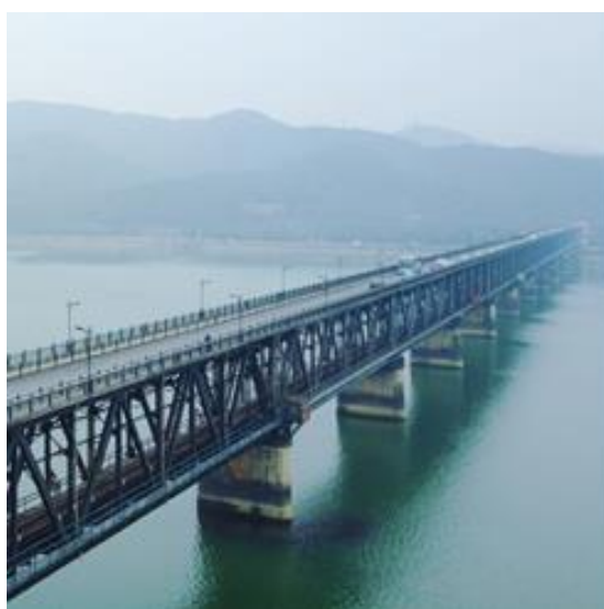
Рисунок 1. Солевой туман в районе двухъярусного металлического моста в китайском городе Ханчжоу через реку Цяньтан в провинции Чжэцзян
