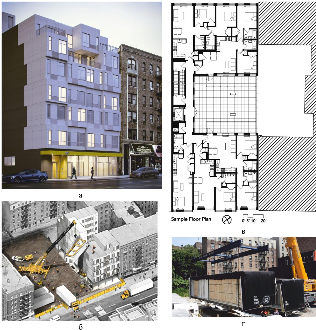
Рис.8. Модульне соціальне житло на Манхеттені (The Stack Modular Housing in Manhattan / Gluck+): а- загальний вигляд; б – будівництво комплексу; в – план типового поверху; г – доставка житлового модулю на будівельний майданчик [3].
