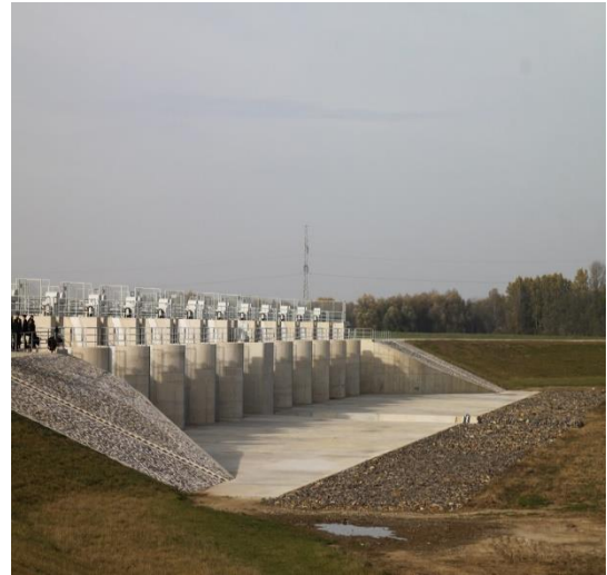
Рис. 2. Водозабірна споруда протипаводкового акумулювального польдера «Самош-Красна», Угорщина, 2014
