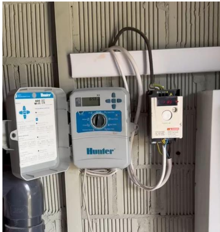
Рисунок 2 - Контролер та автоматика системи Hunter (X2-801-E, датчик дощу MINI-CLICK)
