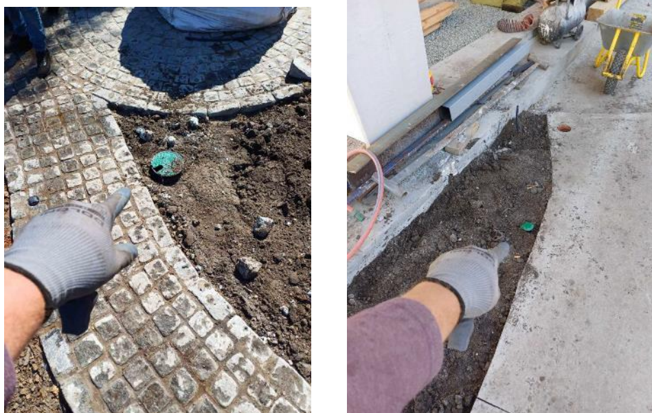
Рисунок 4 – Влаштування водовипуску
