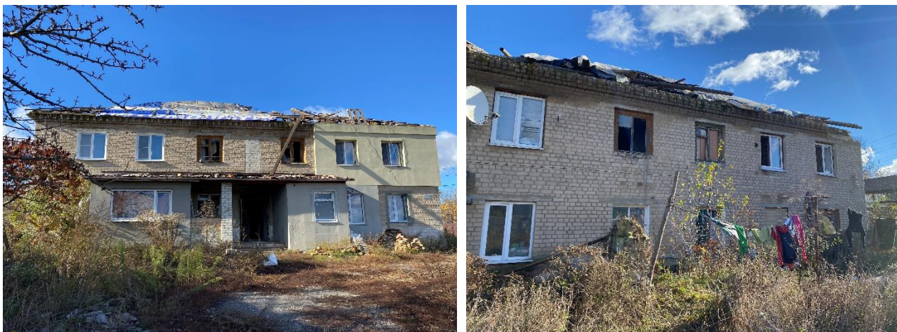
Рисунок 1 – Фасади будівлі (загальний вигляд).
