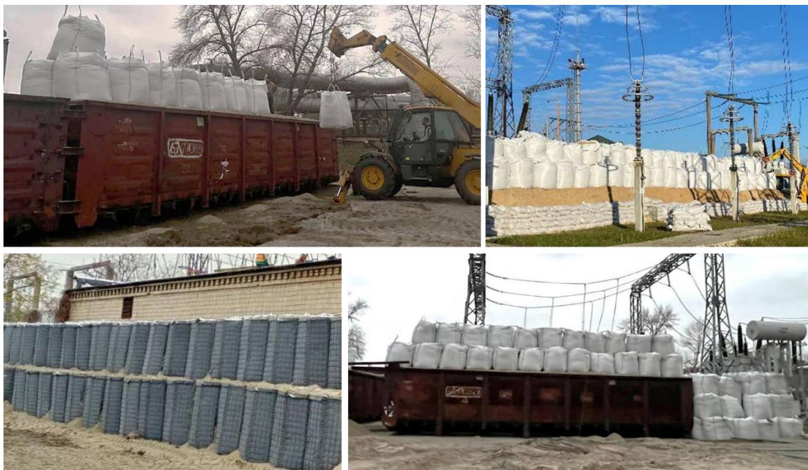
Рисунок 2. Захист об'єктів критичної інфраструктури промислового характеру за допомогою біг-бегів та габіонів (власна розробка авторів)
