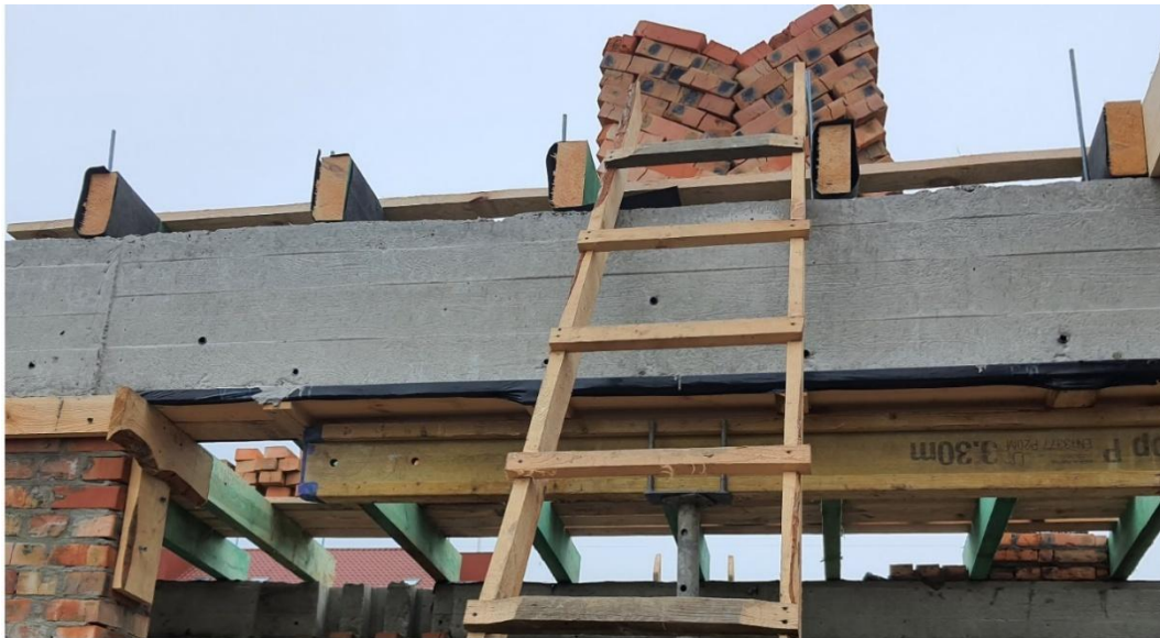
Рисунок 1. Натурна балка покриття, для якої проводилось визначення міцності бетону
