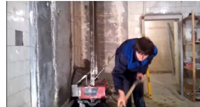
б - подача розчину в бункер
